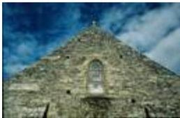
**139. Genêts. Le transept roman**, avec son bras nord et son mur pignon. L'appareil irrégulier des maçonneries est fait de moellons de schiste et de granit. Le schiste est la pierre locale. Quant au granit, il provient sans doute du massif granitique d'Avranches affleurant à quelques kilomètres au sud-est. Le mur pignon est percé d'une grande baie en plein-cintre. Photo d'Alain Dermigny. [Alain\_073]
