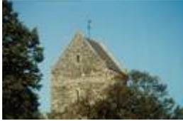
**167. Saint-Léonard-de-Vains. La tour romane.** L'appareil irrégulier des maçonneries est fait de plaquettes de schiste et de moellons de granit, avec quelques rangées de blocs réguliers en granit. Le toit en bâtière repose au nord et au sud sur une corniche supportée par des modillons. Photo d'Alain Dermigny. [Alain\_089]
