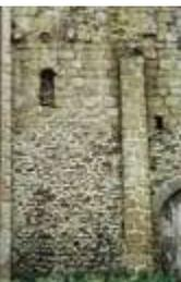
**171. Saint-Léonard-de-Vains. La base de la tour romane** et son mur nord. Dans sa partie inférieure, le mur est formé d'un appareil en arêtes de poisson (opus spicatum) caractéristique du onzième ou du début du douzième siècle. La partie haute présente un appareil régulier de granit. Une rangée de modillons très abîmés subsiste au-dessus des baies. Photo d'Alain Dermigny. [Alain\_092]
