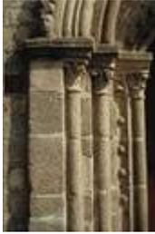
**209. Portail de Sartilly. Les colonnettes de gauche.** De chaque côté du portail, les trois voussures reposent sur trois colonnettes engagées, par le biais d'une imposte moulurée d'un cavet. La partie carrée de l'imposte est ornée d'une petite moulure en creux. L'imposte se prolonge au-dessus du pilastre extérieur sur lequel repose l'archivolte. Photo d'Alain Dermigny. [Alain\_113]
