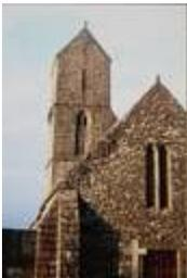
**122. Dragey. La façade occidentale.** L'appareil irrégulier des maçonneries est fait de schiste et de granit, matériaux locaux. Sis à chaque extrémité de la façade, deux épais contreforts sont terminés par un glacis. La grande baie géminée à l'arc légèrement brisé date du treizième siècle. Elle fut débouchée et restaurée en 1860. A la même date, le portail d'origine fut remplacé par un portail sans caractère. Photo d'Alain Dermigny. [Alain\_064]
