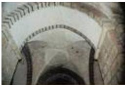
**069. Saint-Pair-sur-Mer. La tour romane**. A l'intérieur, la tour repose sur quatre piliers massifs parfaitement symétriques supportant quatre arcs fourrés et légèrement brisés. Ces piliers déterminent la voûte d'arêtes située sous la tour. Photo d'Alain Dermigny. [Alain\_036]
