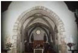
**054. Yquelon. Le chœur roman (intérieur).** La nef ouvre sur le chœur par un arc triomphal très épais, fourré et légèrement brisé, qui repose sur deux pilastres pris dans l'épaisseur du mur. Les deux travées du chœur sont séparées par un arc doubleau, lui aussi très épais et légèrement brisé. Photo d'Alain Dermigny. [Alain\_030]
