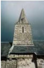
**026. Bréville. L'étage et la flèche de la tour.** L'étage est percé sur chaque face d'une ouverture longue et étroite. Au-dessus s'élève une flèche octogonale de pierre aux angles adoucis par des tores, avec un petit gâble à fines colonnettes situé dans le prolongement de chaque ouverture. Photo d'Alain Dermigny. [Alain\_011]
