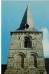
**185. Saint-Loup. La tour romane.** L'étage inférieur est orné au nord et au sud d'une double arcature aveugle en plein-cintre. Celle-ci est surmontée d'un cordon saillant se prolongeant en un bandeau droit sur le nu du mur se poursuivant ensuite sur les faces est et ouest. Photo d'Alain Dermigny. [Alain\_100]
